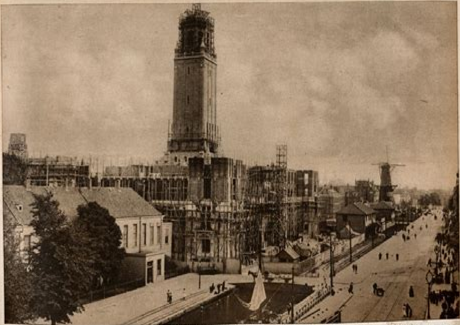
DE VORDERINGEN VAN DEN BOUW VAN HET ROTTERDAMSCH STADHUIS.
