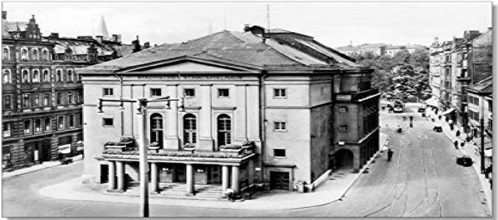
Chemnitz: Schauspielhaus an der Theaterstraße, um 1940. Das 1808 errichtete Schauspielhaus wurde 1945 zerstört. Rechts Richtung Karlsbergaufahrt.
